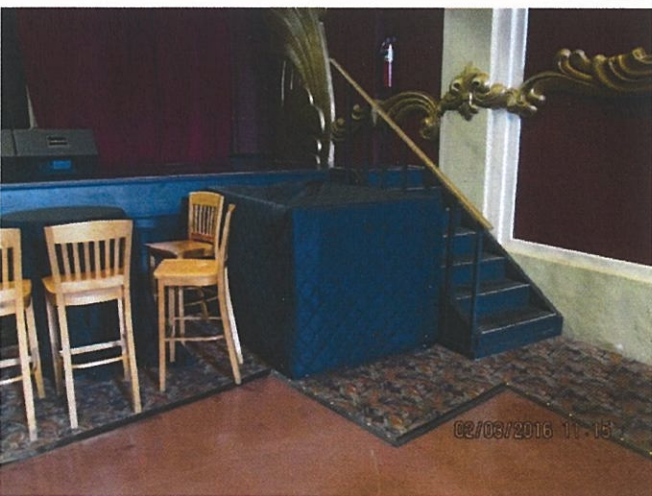
Item 21: ADA lift.
